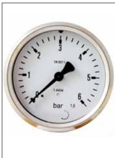
(Afb. 3) Drukmeter die in de nabijheid van de ketel is geplaatst.
