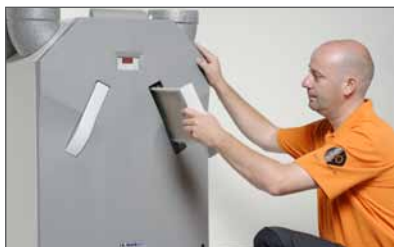
Terugplaatsen filters in de WTW-unit
